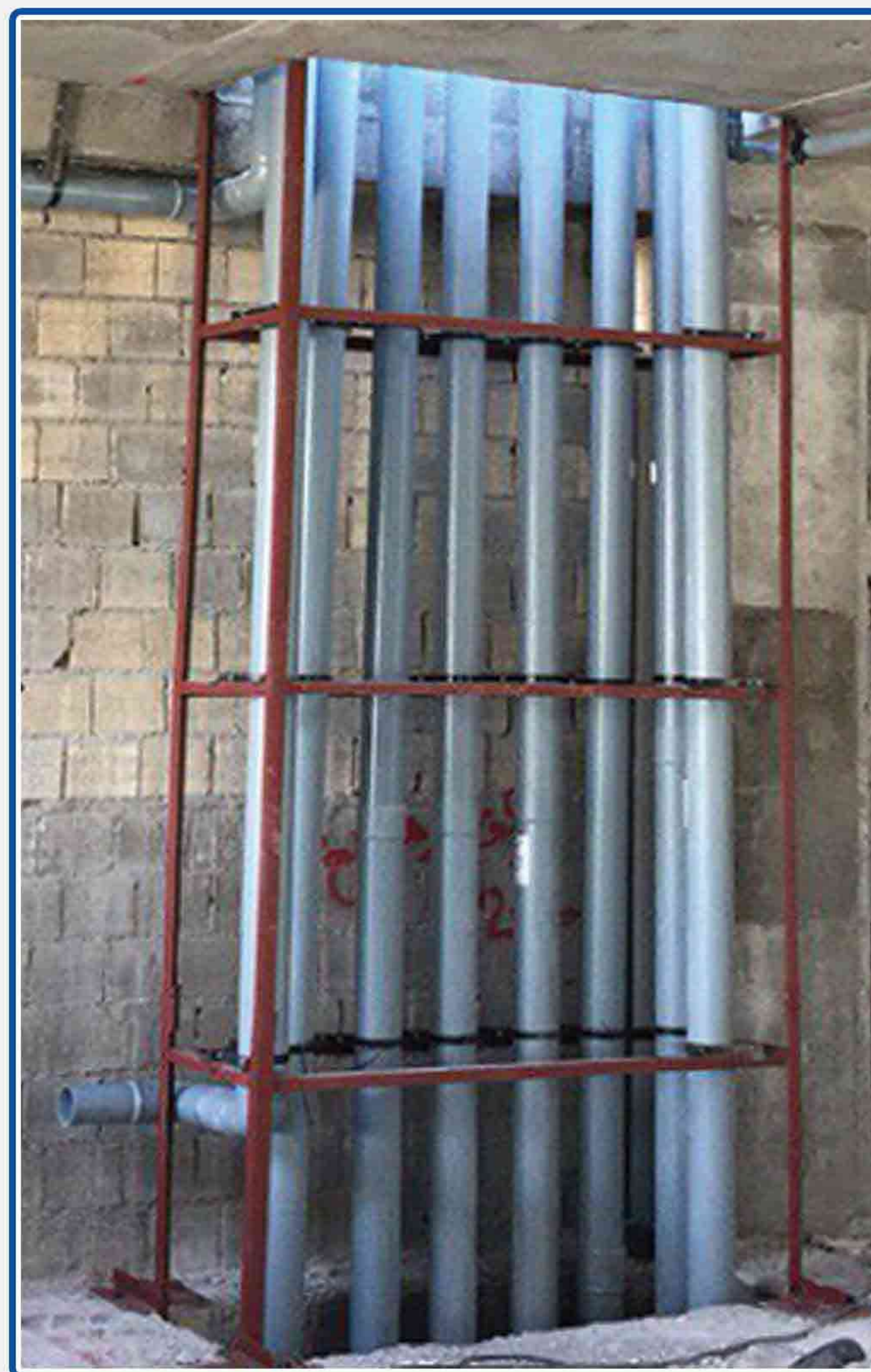
شکل ۱. شاسی کشی برای مهار لوله های عمودی
