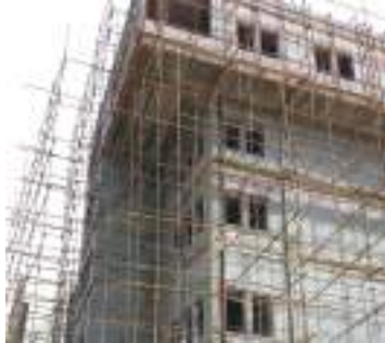
Tejarat Bank project
