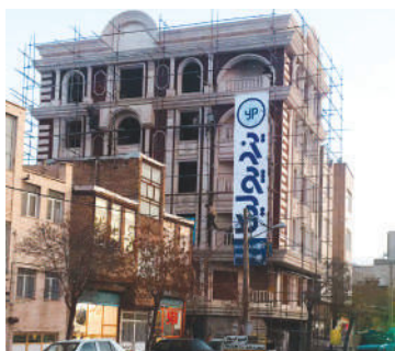
پروژه خیابان قیام اراک
