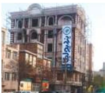
پروژه خیابان قیام اراک
