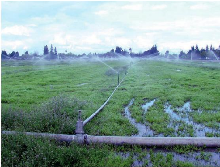
▲ سیستم لوله آلومینیوم قابل حمل در حین عملیات.
