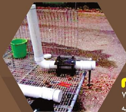
شکل ۳ نصب افقی در نهال‌های ملالوکا
